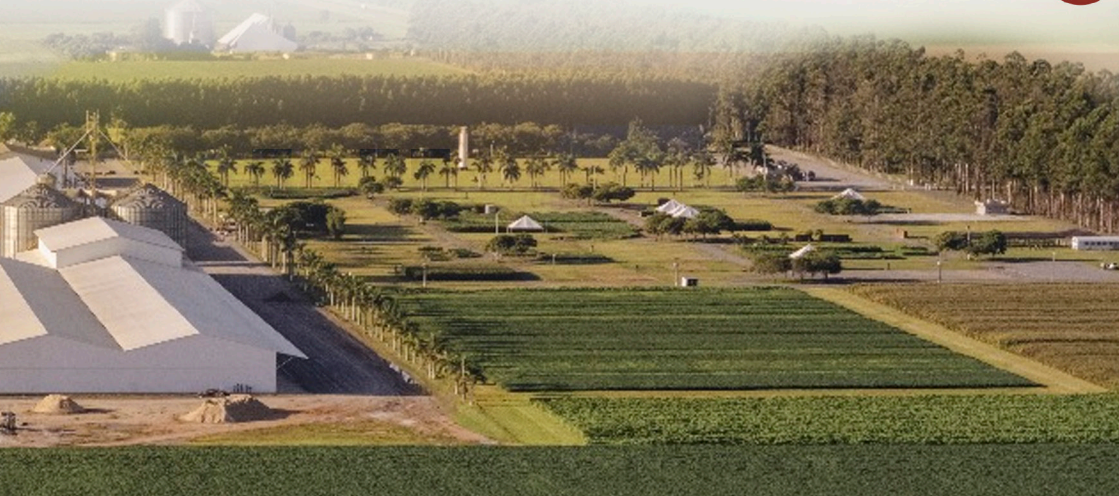
Estrutura Unidade de Beneficiamento de Sementes
